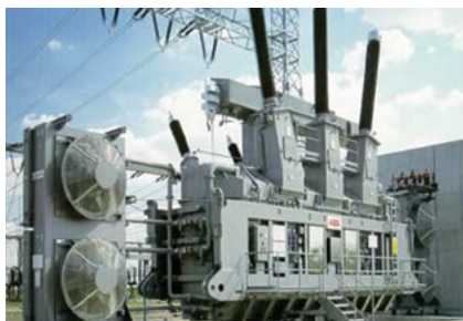
图 1. 高压输电中使用的变压器。
