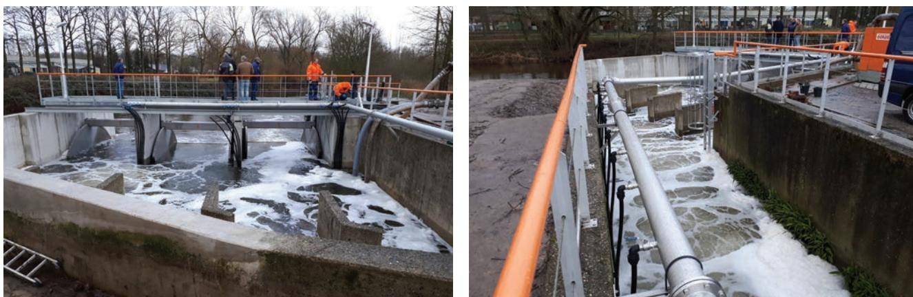
РИС. 7. Канал аэрации станции очистки сточных вод города Эйндховен в процессе эксплуатации, когда сточные воды насыщаются кислородом перед попаданием в реку Доммел. Слева: вид на регулируемую плотину на выходе из канала аэрации. Справа: вид на канал аэрации на входе.
