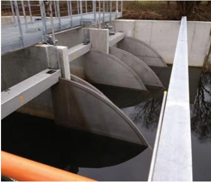
РИС. 3. Вид на регулируемую плотину на выходе из канала аэрации.
