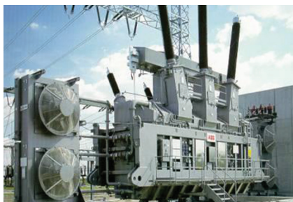
図 1. 高圧送電線の変圧設備の写真。
