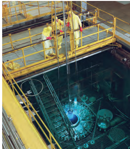
図 1. ORNL で HFIR の燃料要素を交換する技師たち。HFIR は 1966 年から稼働しており (452 燃料サイクル超)、現在 ORNL で稼働する唯一の原子炉。画像提供: 米国立オークリッジ研究所、米国エネルギー省
